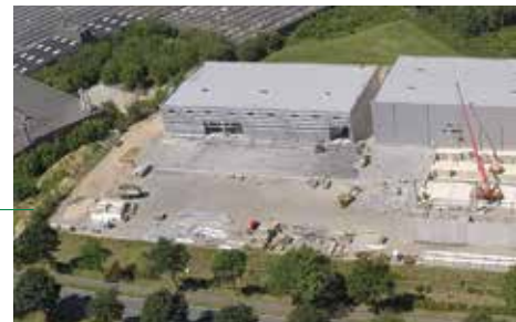
Baustelle der Kartoffelsortieranlage in Schwalmthal-Waldniel im Mai 2017.
